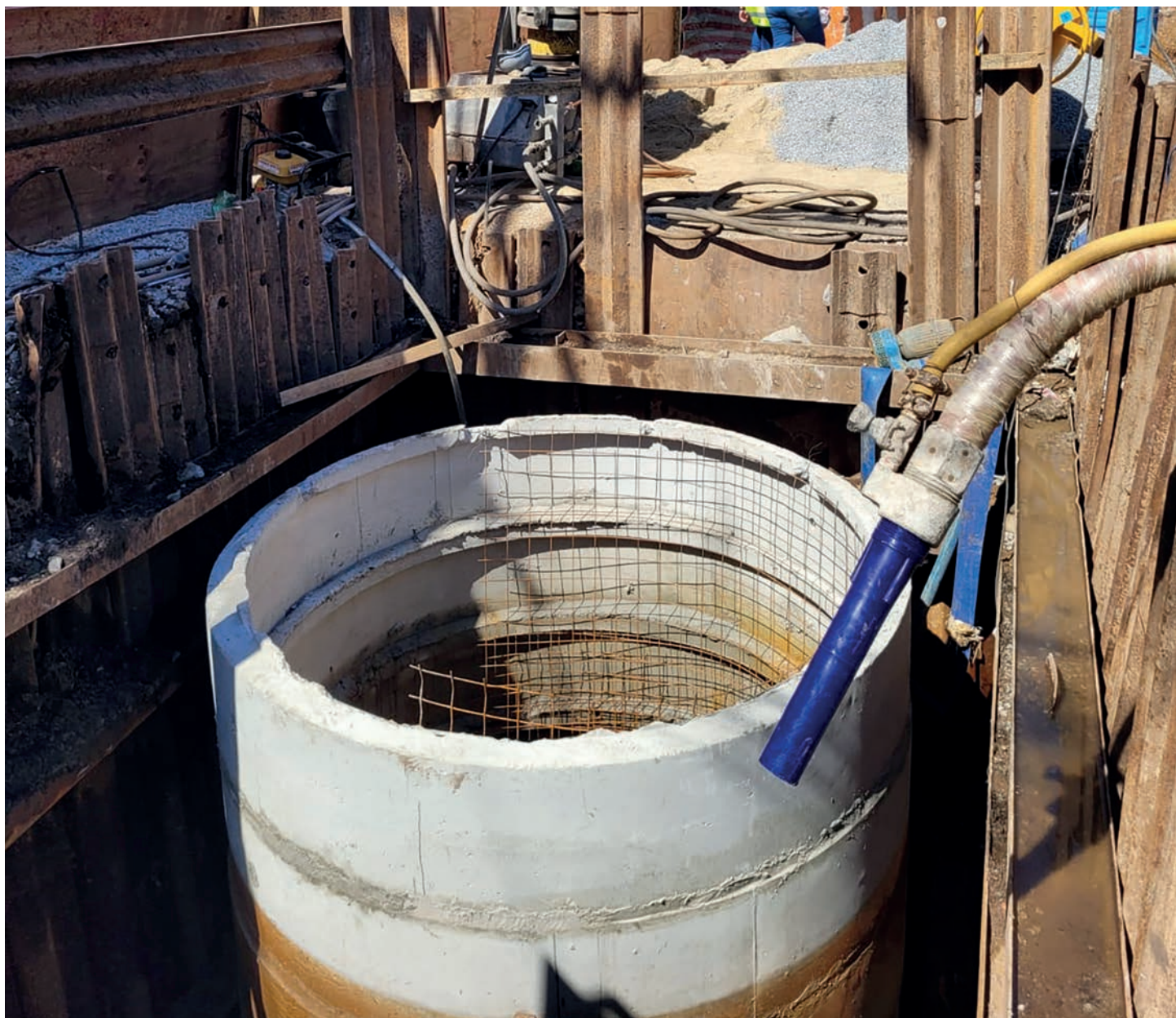
Obras de execução de estação elevatória pela Sabesp, agosto de 2023. Foto: Luiz Nickel
