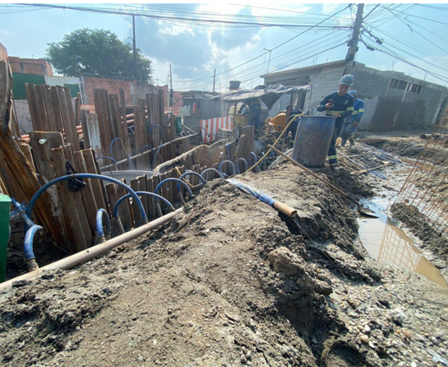
Construção das Estações Elevatórias de Esgoto (EEE). Foto: Luiz Nickel.
